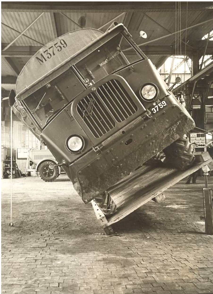
Die Aufnahme zeigt einen Kipptest in den Werkshallen in Arbon.
